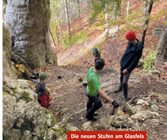
Die neuen Stufen am Glasfels
