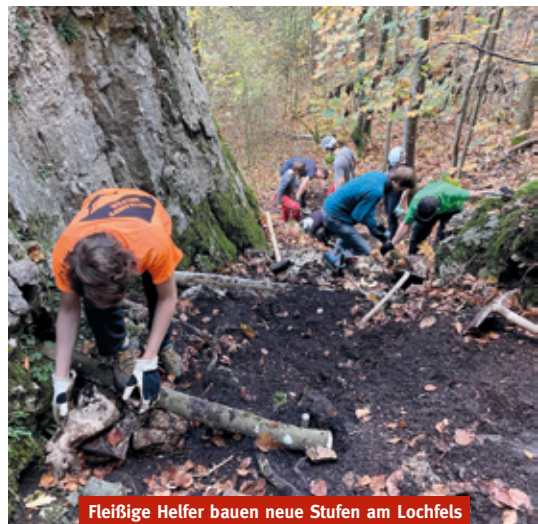
Fleißige Helfer bauen neue Stufen am Lochfels
